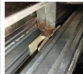
Rozaderas de puertas de piso con desgaste y oxidación
